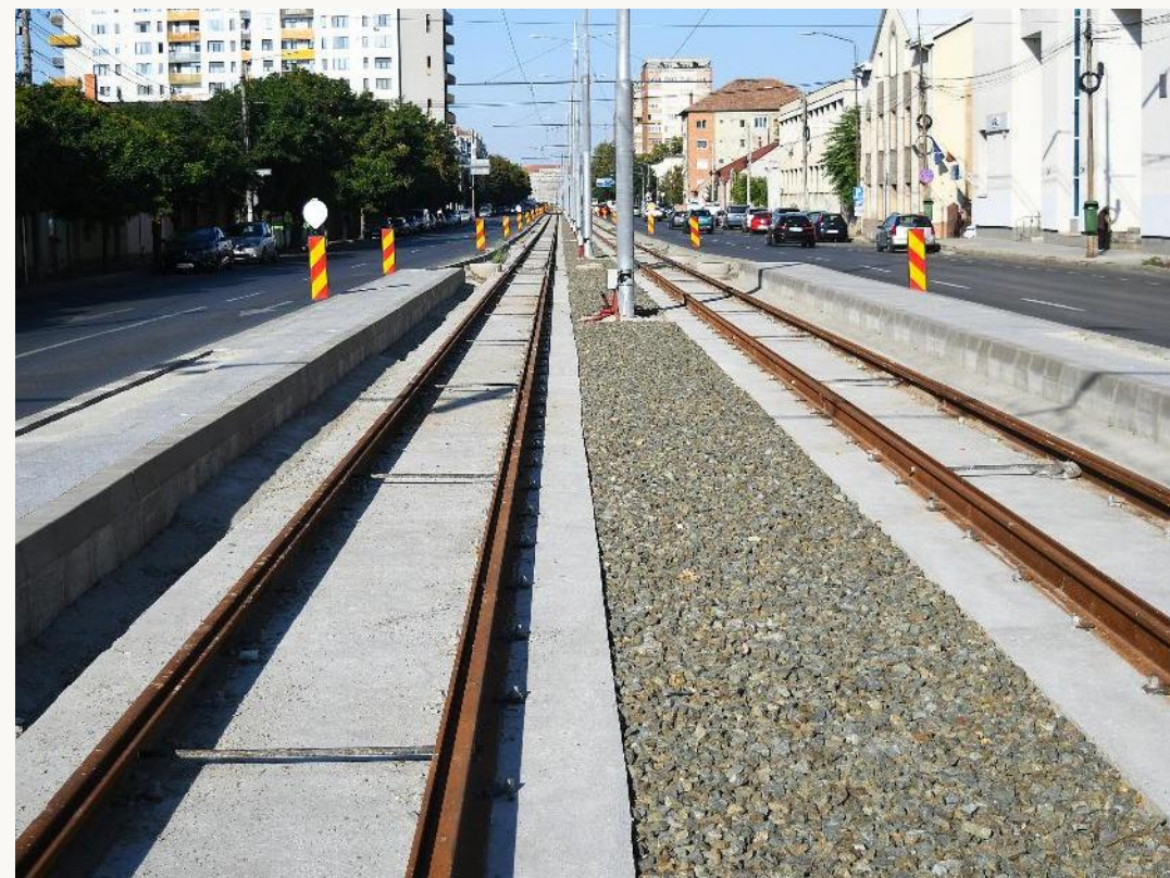
ÎN TIMPUL LUCRĂRILOR Calea Iuliu Maniu
