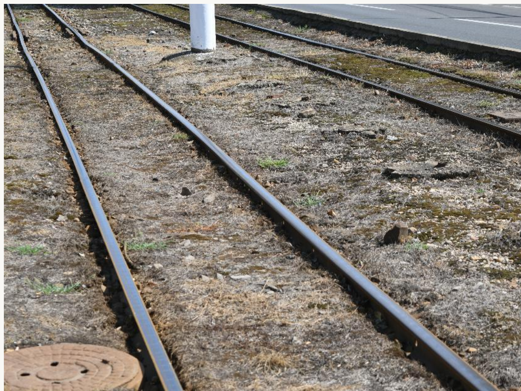
ÎNAINTE DE LUCRĂRI Stâlpi de beton, șine în iarbă
