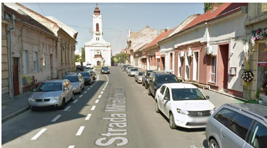
Figura 2.8.9.11. Str. Mihai Eminescu, sector din vecinătatea Bisericii Reformate, parcare pe ambele părți, vehicule pe pista pentru biciclete. Sursa: Google Maps.
