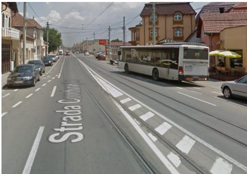
Figura 2.8.9.33. Stație de autobuz în carosabil (pe pista de biciclete/ parcare vehicule). Sursa: Google Maps.
