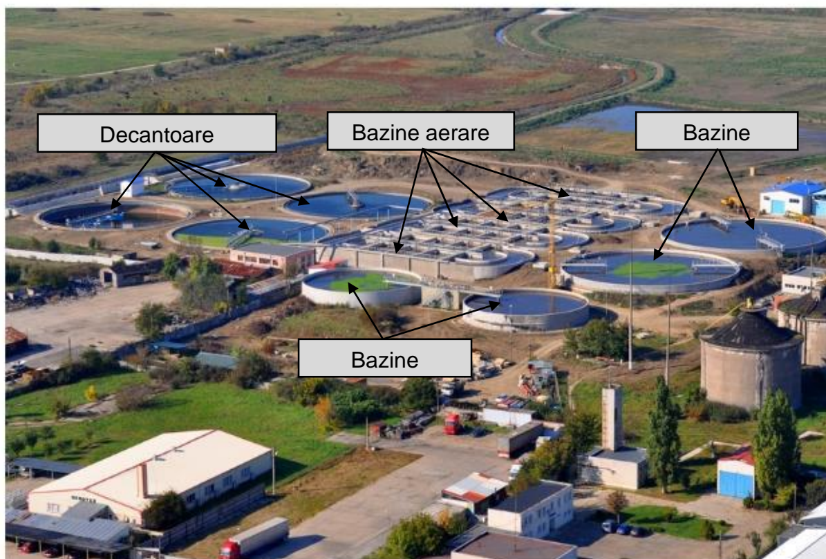
Figura 2.9.3.1.3 Statia de epurare Arad – vedere de ansamblu treapta biologica si bazine de retentie
