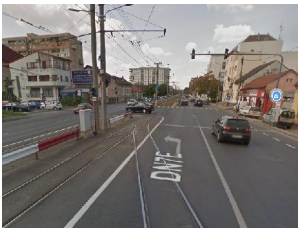
Figura 2.8.9.29. Calea Iuliu Maniu - încadrare linie tramvai dinspre N. Titulescu/ Micalaca cu traversare oblic peste zona de stocaj la intersecție semaforizată, zonă ce poate fi blocată de vehiculele rase în așteptare la semafor.
