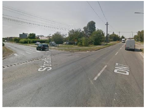
Figura 2.3.9.1.12. Intersecție CNA cu Str. Me terul Manole neamenajat , viraje la stânga necontrolate, lips separatori de circulație. Sursa: Google Maps.
