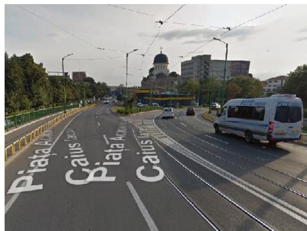
Figura 2.8.9.30. Încadrare oblică cu semnalizare insuficientă a liniei de tramvai dinspre Gar spre Cartier Grădite pe rampa pasajului peste CF de pe Str. Petru Rareș. Sursa: Google Maps.
