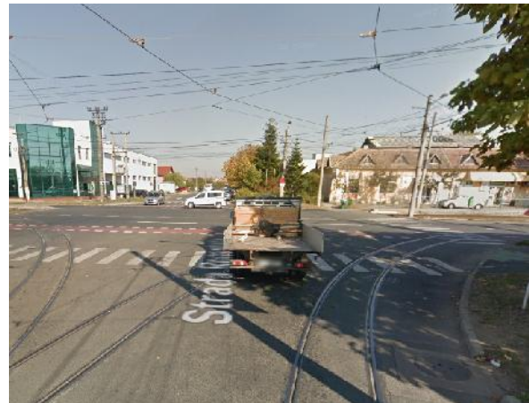
Figura 2.8.9.28. Intersecție Calea Radnei cu Str. Renașterii, cu linie în carosabil și ramificație care ocupă tot spațiul intersecției/benzile de circulație. Sursa: Google Maps.
